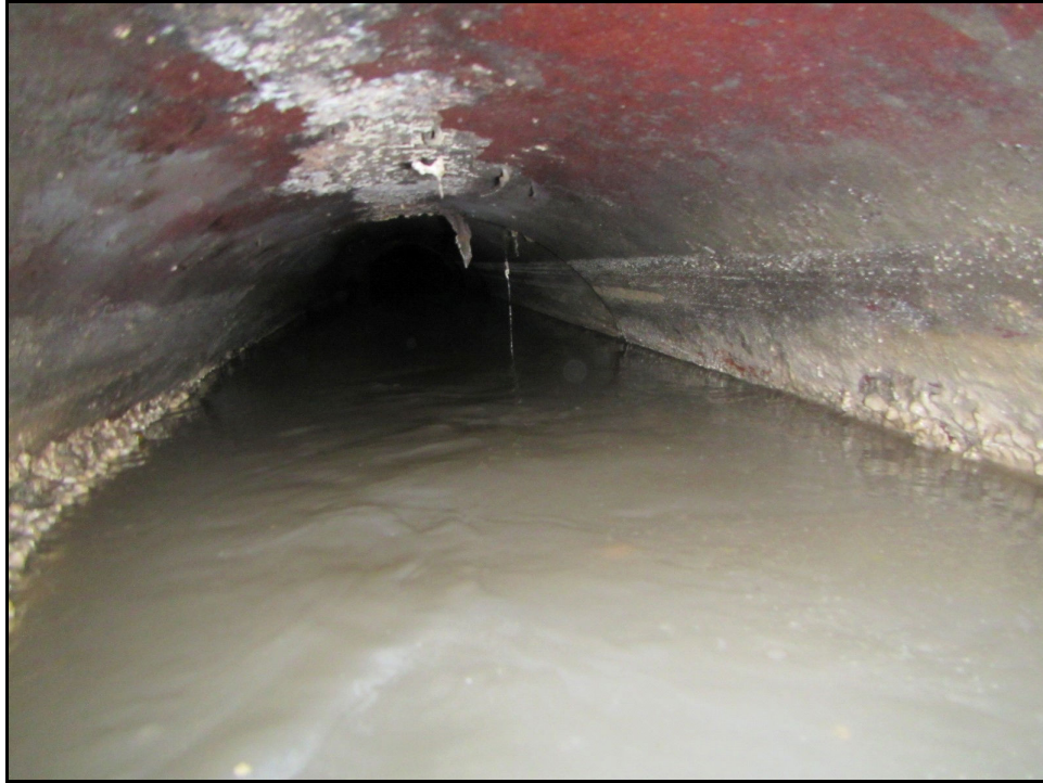
Effluent Pipe
